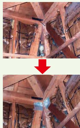
既存の筋かい端部を金物で補強
