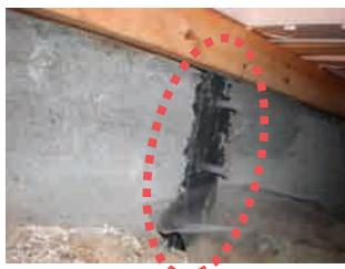
小さなひび割れの場合は、エポキシ樹脂を注入して補修します。
