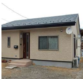
ローコスト住宅施工事例
